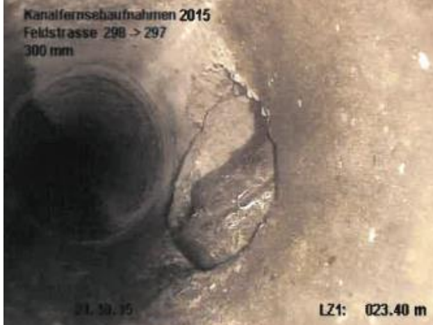
Abbildung 16 und 17: IST-Zustand Kanalisationsleitungen «Feldstrasse» (Quelle: KTV ISS Kanal-Services AG)
