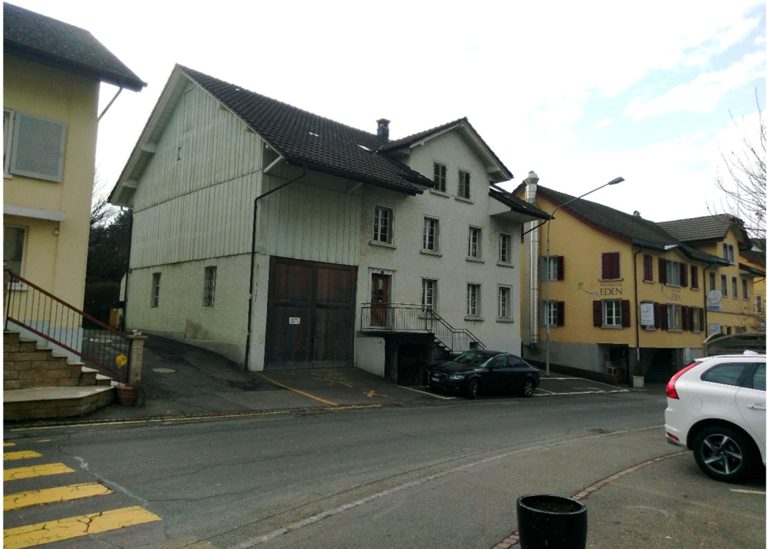
Ansicht Liegenschaft Nord-Ost
