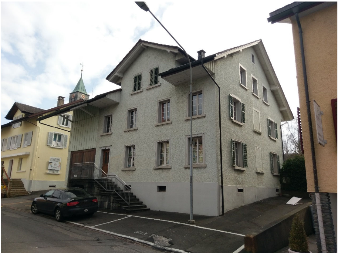
Ansicht Liegenschaft Nord-West
