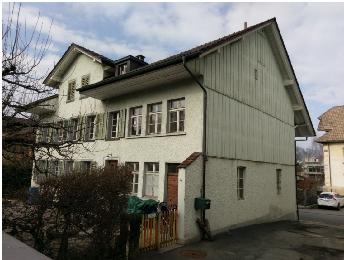
Ansicht Liegenschaft Süd-Ost
